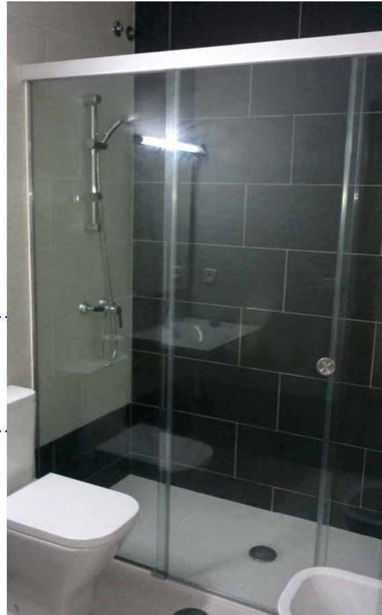
Mampara para ducha, de una puerta abatible sobre bisagras instaladas en la pared.
