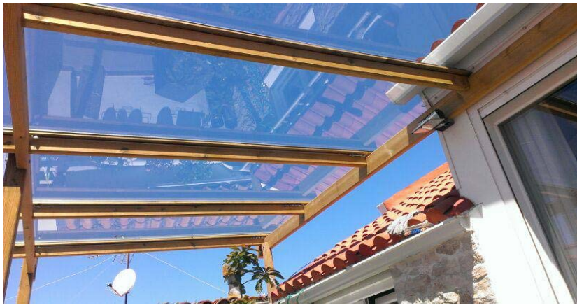
Tejadillo acristalado con vidrio laminar de seguridad y colocado con perfil de tapeta, una manera de cubrir zonas aprovechando al máximo las condiciones de luz natural
